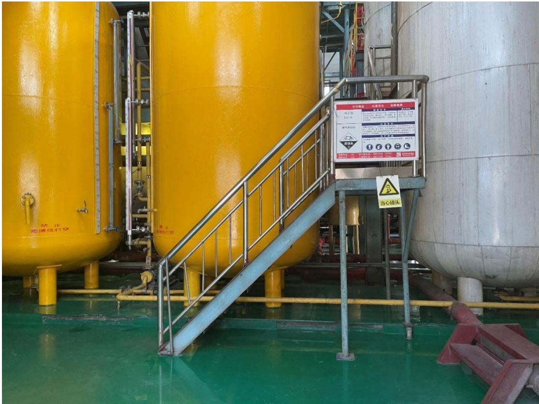
图 5-4 甜蜜素车间地面已做防渗处理
