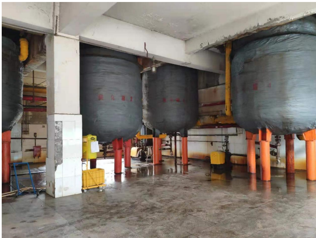
图 5-1 一车间地面仅铺设大理石
